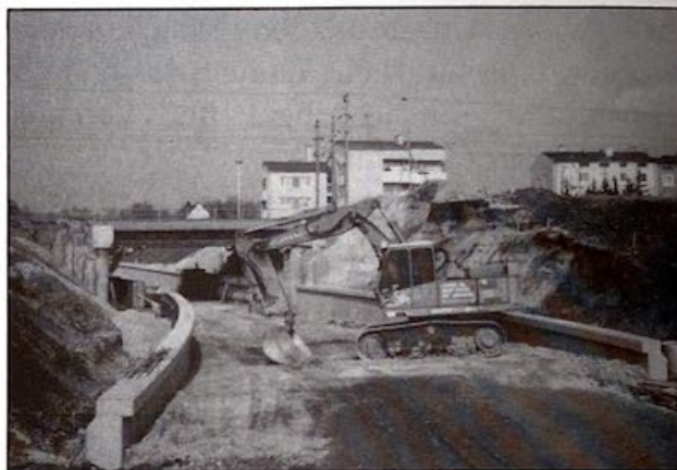
Die Grundbauarbeiten bei der neuen Bahnunterführung sind schon sehr weit fortgeschritten
