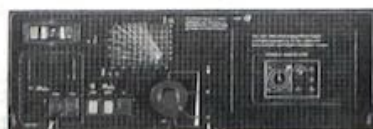
Gaskesselgrundschriftfeld (gehört zum Lieferumfang). Alle Combigas-unit-Heizkessel besitzen ein Grundschriftfeld und bieten somit die Möglichkeit, die Kesseltemperatur manuell der jeweiligen Außentemperatur anzupassen.
