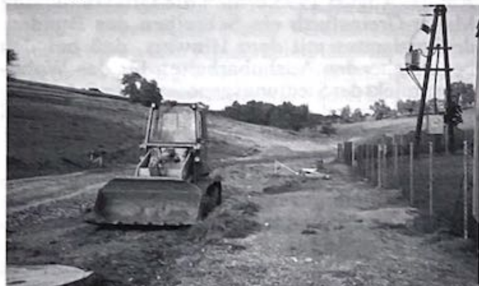
Am 21. August erfolgte der Baubeginn der Feuchgrabenstraße.
