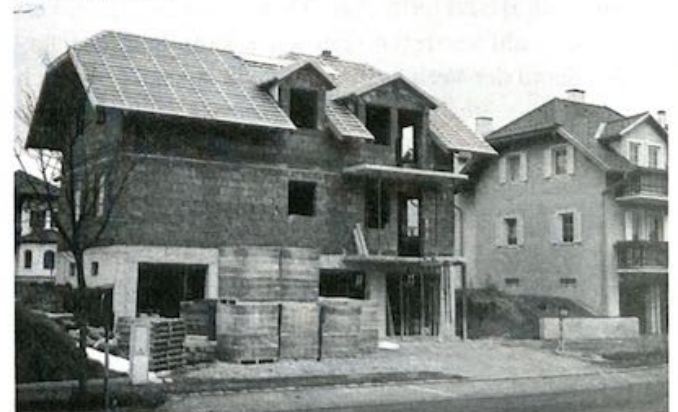
Gebaut wird derzeit im Ortsteil Oed das dritte Wohnhaus
