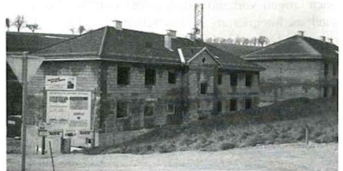
Im Graben in Öhling werden zwei Wohnblocks errichtet. Die 14 Wohneinheiten werden im Jänner 2000 bezugsfertig.
