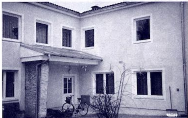
Übergangswohngemeinschaft Lorenz-Buschlstr. 3, renoviert 1994 bis 1998
