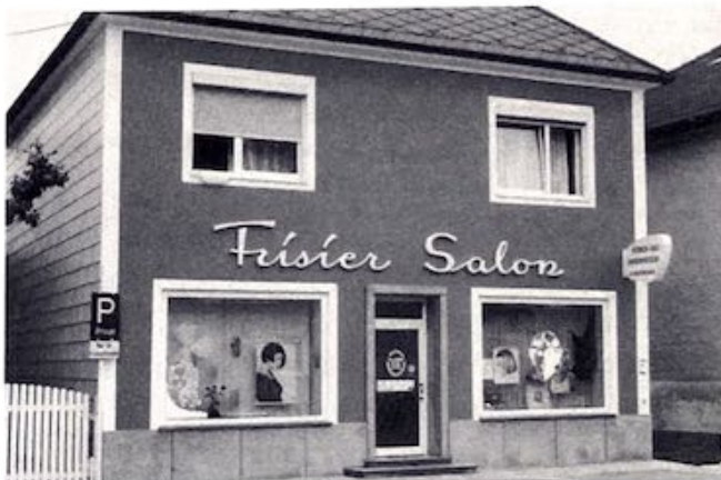
Frisör Grissenberger, Mauer, Hauptstraße 24a
