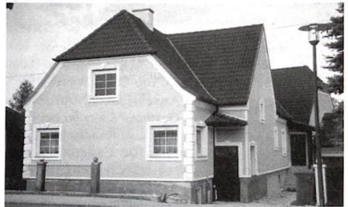
Haus der Fam. Schatara in Mauer, Hauptstr. 20
